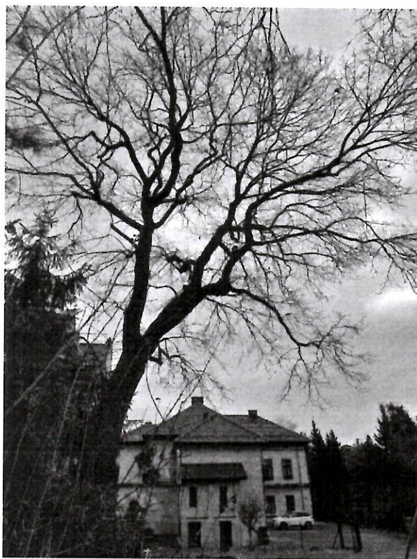
Widok od strony zachodniej (stan obecny)
